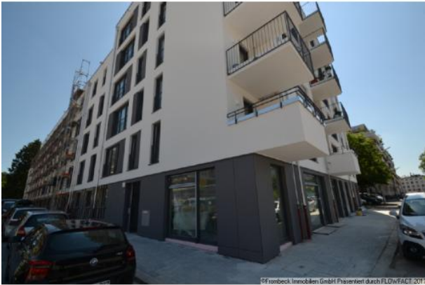
Ansicht nach Fertigstellung
